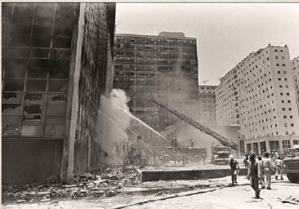
Figura 38. Combate ao incêndio no Edifício Barão de Mauá, ocorrido no centro do Rio de Janeiro, em 11 de dezembro de 1981. Fonte: O Globo, edição de 12 de dezembro de 1981.
