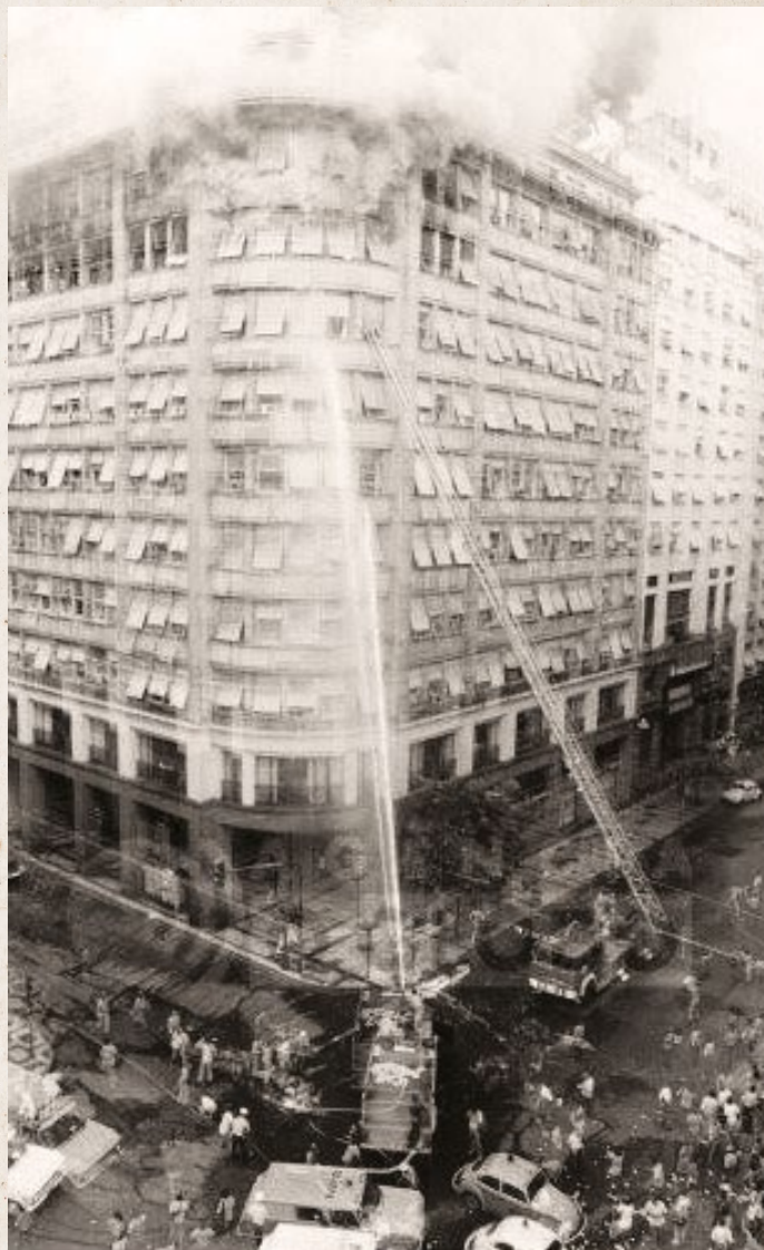
Figura 39. Combate ao incêndio no Edifício Andorinhas. Fonte: Memória Globo (28/10/2021).
